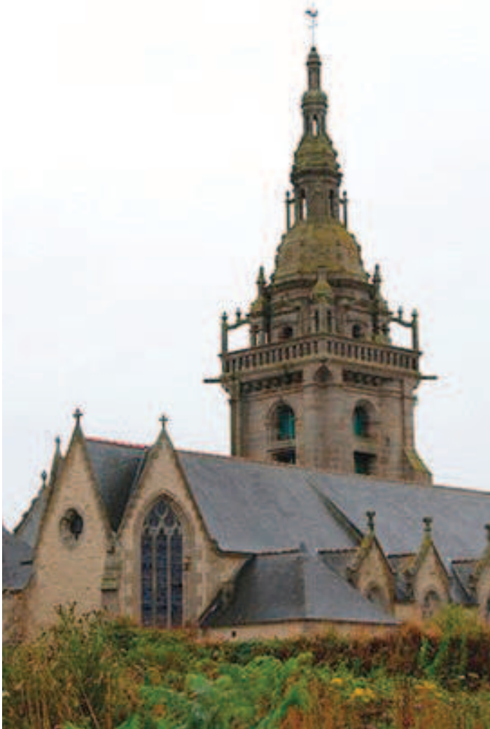
Eglise de Lampaul-Ploudalmézeau
