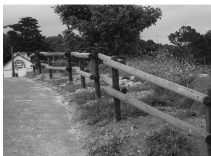
Remise en sécurité du front de mer
