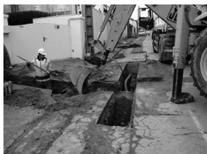
Effacement des réseaux rue Saint-Yves
