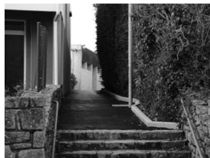
Pose d'un enrobé sur le chemin des écoliers
