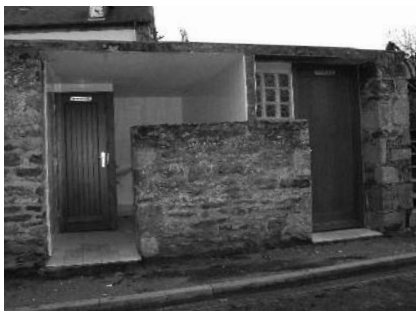
Rénovation des toilettes place de l'église
